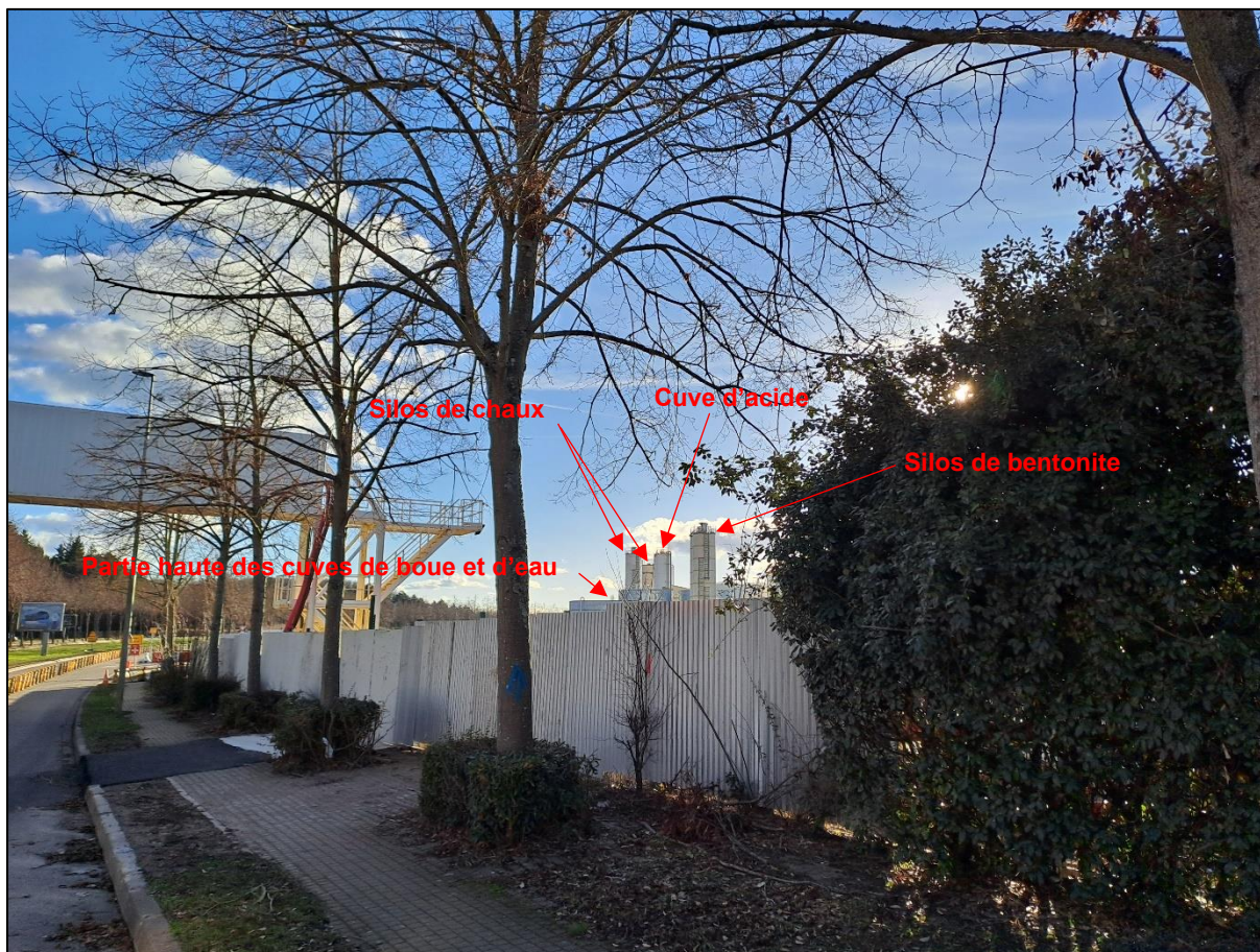
Photo 5 : Vue du site depuis l'extrémité nord de l'avenue de l'Europe
